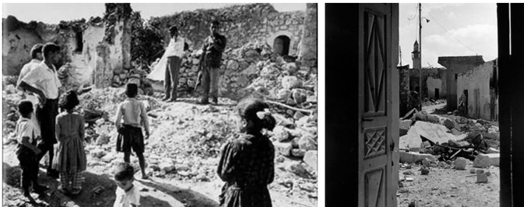
Qalqilya: aspect al distrugerilor din 1967
