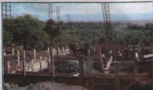
Aspecte din tabăra de muncă - evoluția șantierului: săparea terenului, confecționarea cofrajului, umplerea acestuia cu beton pentru construirea fundației chililor
