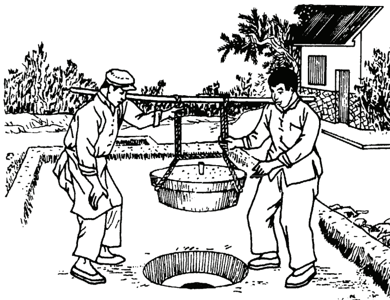
Fig. 4 -23. Fixarea capacului detașabil
